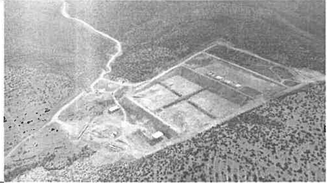
Katı Atık Tesisi İnşaatı
